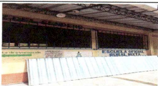
Foto 11: Sustrucción de lámina, por lámina troquelada aluzinc calibre 26.
