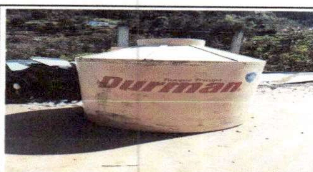
Foto 12: Sustrucción de depósito de agua 2,700 LT
