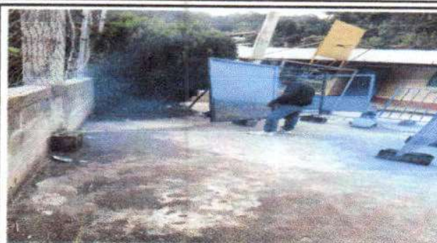
Foto 8: Sustrucción de portón.
