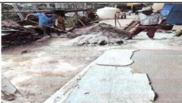
Foto 3: Sustitución de piso prefabricado por torta de concreto.
