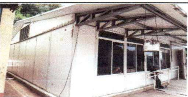
Foto 5: Sustitución del vidrio.
