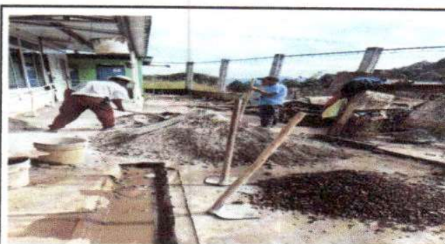
Foto 10: Reparación de banquetas de concreto atrás de los módulos.
