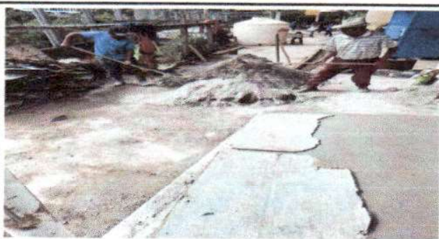
Foto 9: Reparación de banquetas de concreto atrás de los módulos.
