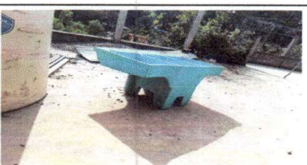
Foto 6: Sustitución de pila de concreto.
